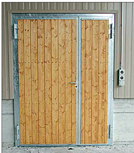
Flügeltüre mit wasserfester Verkleidung, für den Nassbereich (Innenansicht, Fallschiebefenster).
