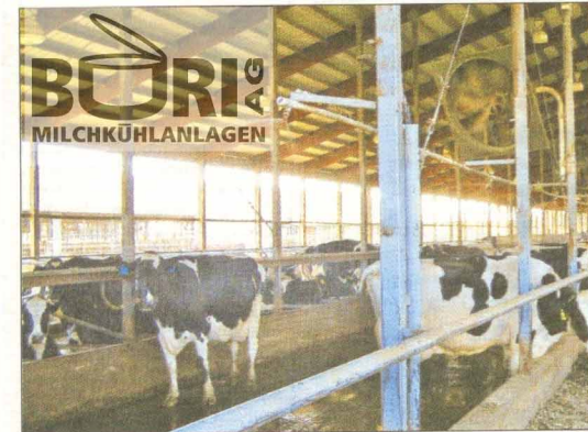
Sprinkleranlagen und Ventilatoren sind wirksame Einrichtungen, um ein Überhitzen der Milchkühe zu vermeiden. Durch die Verdunstung des Wassers wird die Hautoberfläche abgekühlt. Foto: Gerhold
